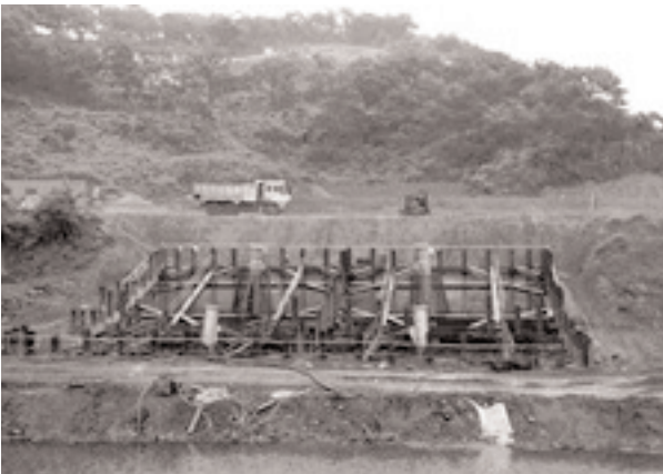
광파기와 반사 시트 타켓을 이용한 철탑기초
